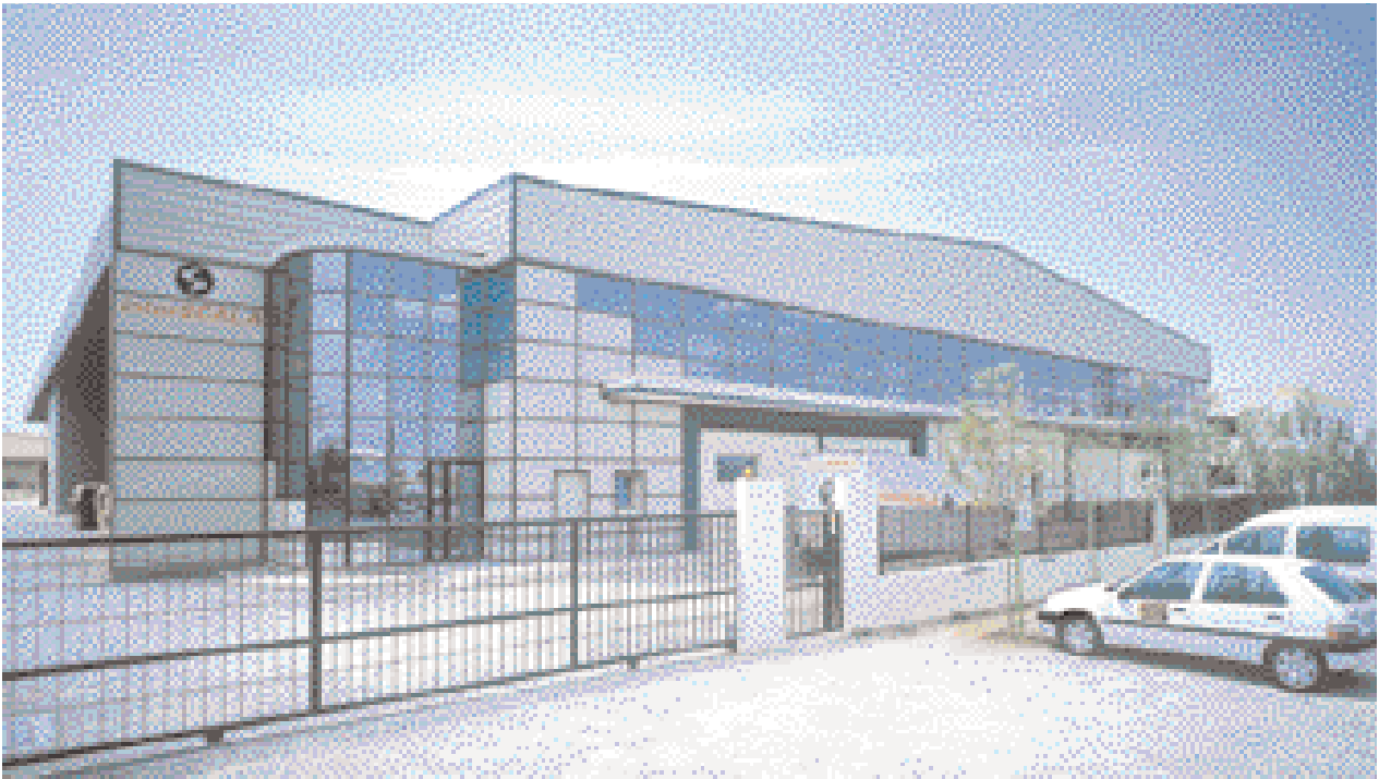
Κτίριο Α: σκάλες - κουφώματα
